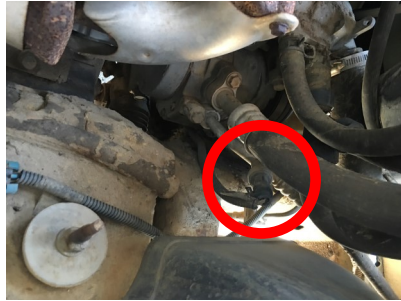
1. Apague el vehículo y localicé el presostato del transductor.
